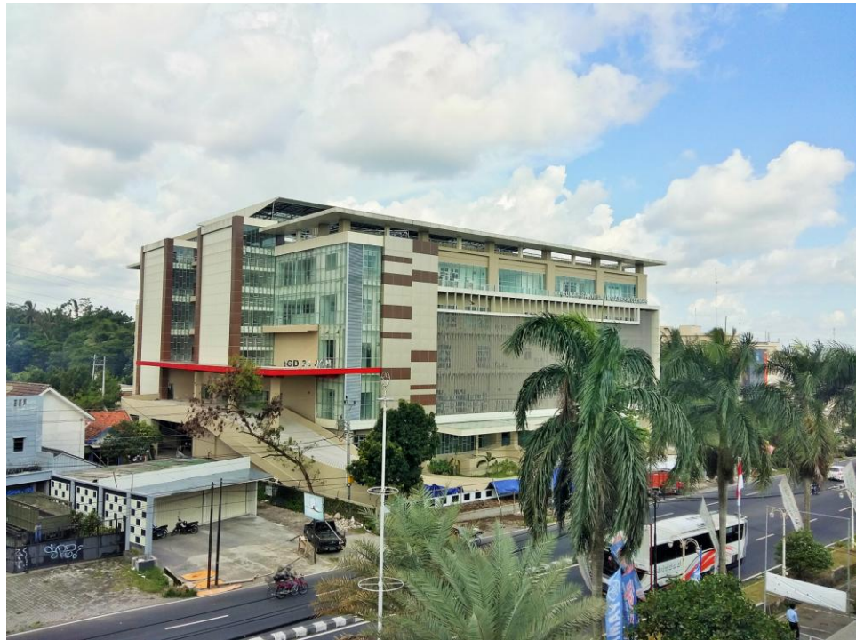
Pembangunan Gedung Pelayanan Terpadu RSUD Sleman sebagai salah satu bentuk upaya peningkatan kualitas pelayanan publik
