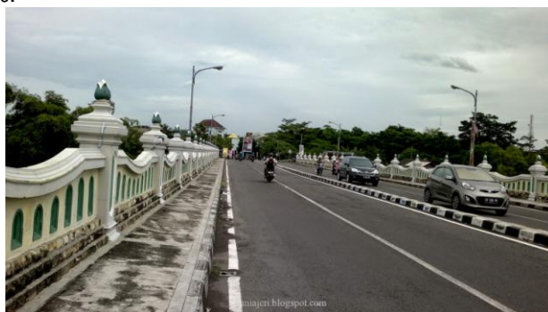
Salah satu jembatan di wilayah Kabupaten Sleman, prasarana dan sarana perekonomian
